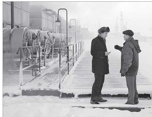
Градирия позволяет снижать температуру сжатого воздуха
